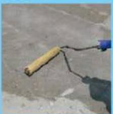
將EV未稀釋液稀釋為10倍製成底漆。使用滾筒刷以所定的份量(0.4kg/m<sup>2</sup>)均勻塗布底漆。底漆的晾置時間依底層的種類和天候而異，一般大約為1小時~2小時左右。
