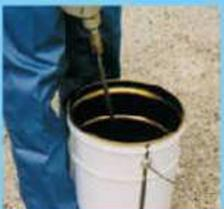
在EV未稀釋液中逐量加入EV摻合材料，以高速攪拌機攪拌3分鐘左右後，確認已呈無結塊的均勻狀態。
