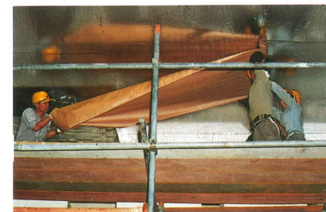
③天花板施工
