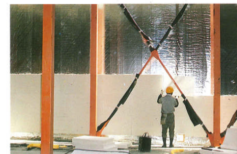
⑤隔熱材施工
