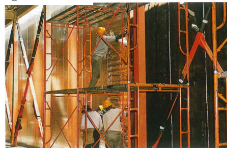
②牆面施工
